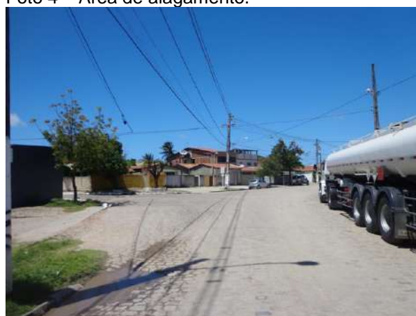
Foto 6 - Trecho com pequenos afundamentos na trilha da roda externa.
