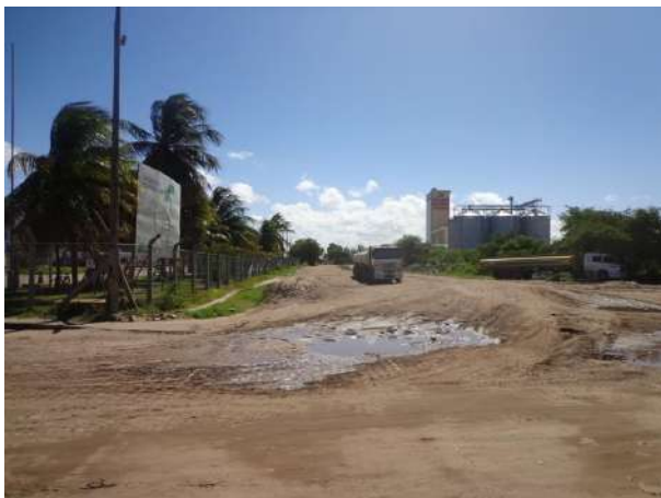
Foto 1 – Área de alagamento.
