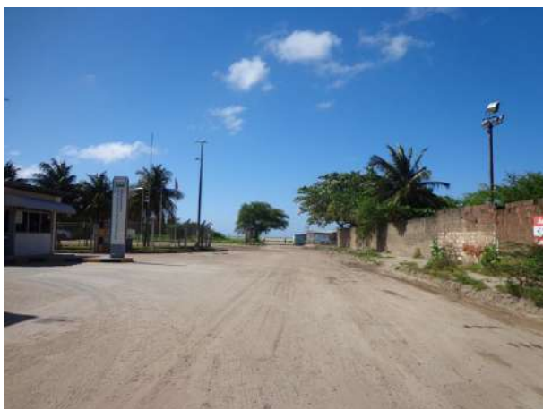
Foto 5 – Trecho totalmente destruído, na interseção com a R. Cassiano c. Nóbrega.
