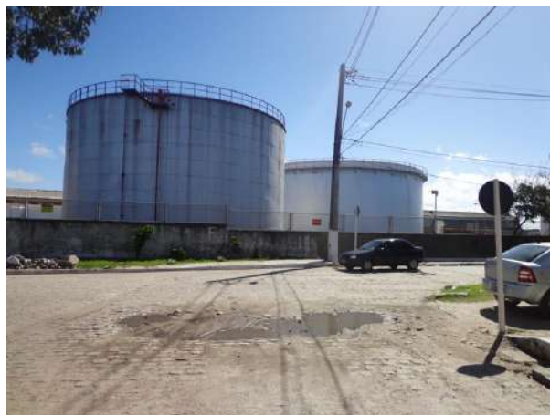
Foto 6 – Final do trecho na interseção com a rua Francisco Serafim.
