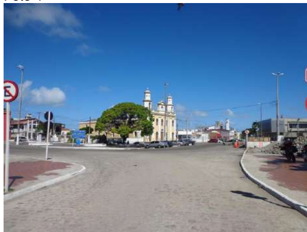
Foto 6 – Final na interseção com a BR – 230.
