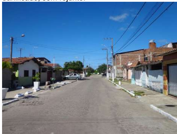
Foto 4 – Trecho com tapa buracos.
