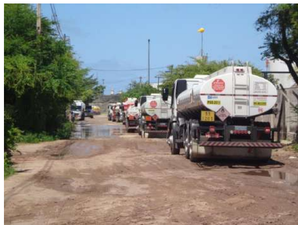
Foto 2 – Trecho destruído, com muitas ondulações.
