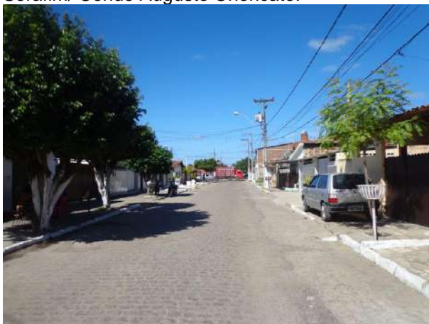
Foto 3 – Trecho com tapa buracos.
